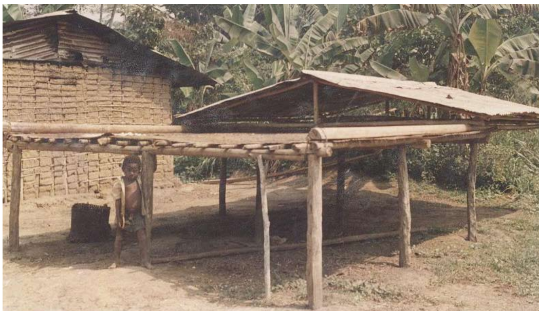
B: Toiture mobile; la toiture est coulissée pour protéger le produit sur la plateforme de séchage en cas de pluie.
