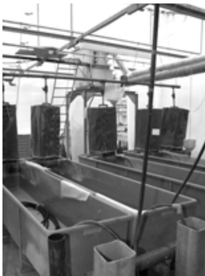
Photo 3: Batterie de bassins du circuit fermé n° 3 (CF 3) avec tour d'épuration et château d'eau à l'arrière plan
