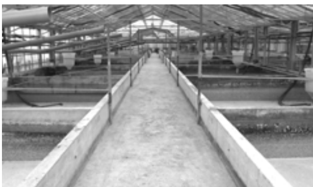
Photo 5: Ensemble de bassins en béton de 20 m³ avec nourrisseur pendulaire à la demande
