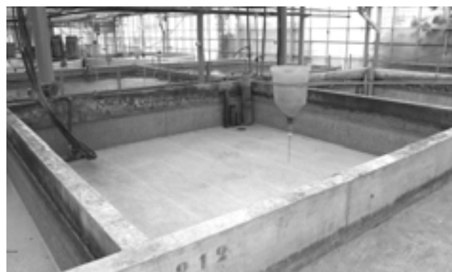
Photo 6: Bassin en béton de 20 m³ avec tour de dégazage et nourrisseur pendulaire
