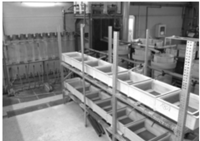
Photo 1: Ecloserie en circuit fermé: dans le fond, batterie de bouteilles de Zoug au-dessus du filtre bactérien pour l'éclosion des œufs et château d'eau et à l'avant plan, bacs de larviculture avec leurs claies
