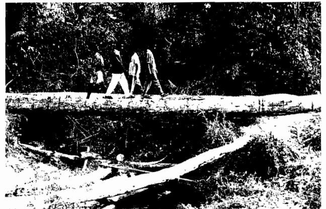
Photo 4 : Lancement d'un tronc de Cynometra alexandri sur une rivière pour servir de pont
