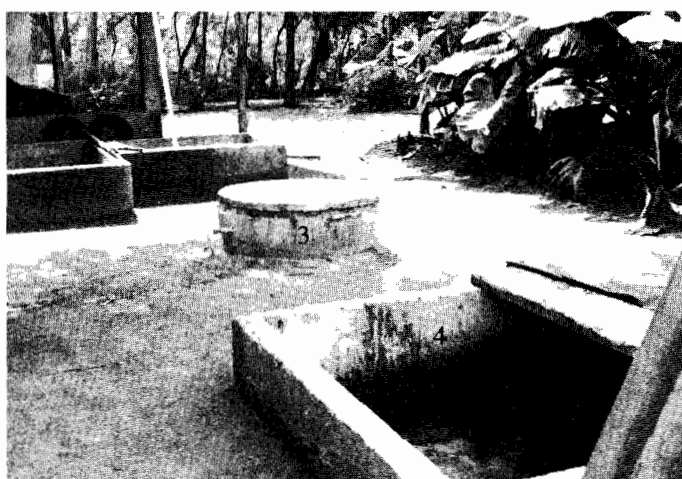
Photo 3 Citerne de stockage du biogaz
